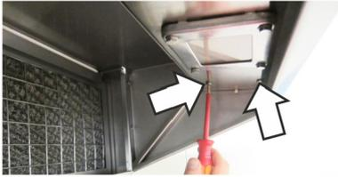
Apriete los 2 tornillos de fijación de la chapa de ajuste.
