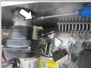
Introduzca el tubo de ventilación hasta donde sea posible en la junta de la válvula de ventilación.
