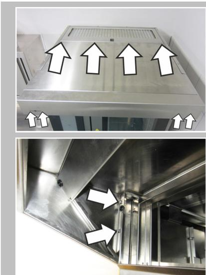
Afloje los 4 tornillos de la cubierta y 2 tornillos a la izquierda y derecha del orificio de aspiración, respectivamente, y retírelos.
