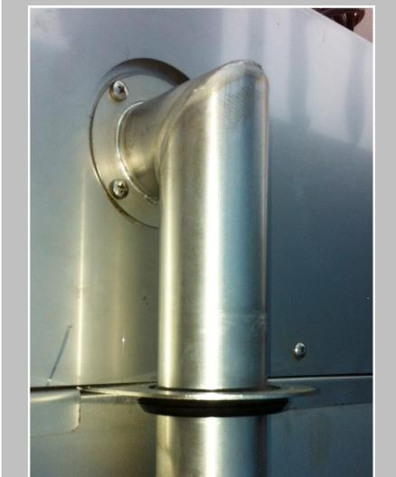
Monte el tubo acodado adjunto para la campana del kit de sobreposición en la brida de fijación.
