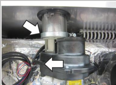
Monte la abrazadera de manguera desde abajo encima del tubo de ventilación y gire la válvula de ventilación hasta situarla debajo del tubo de ventilación.
