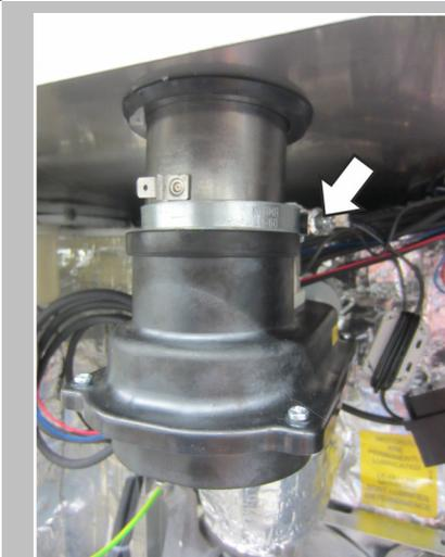
Отверните винт шлангового хомута на вентиляционном патрубке при помощи торцового ключа размера 7 настолько, чтобы шланговый хомут можно было протянуть над плоским штекером.
