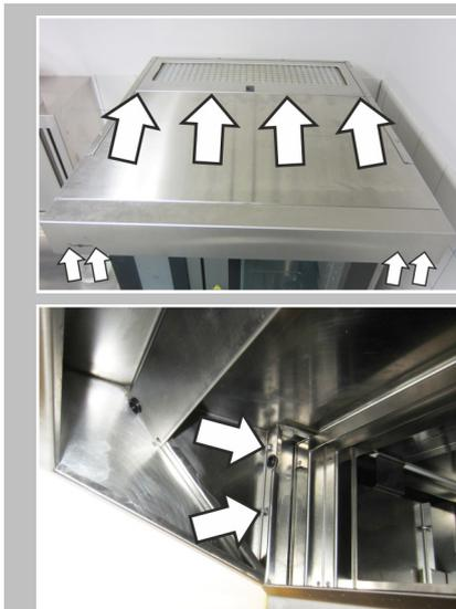
Отверните 4 винта на кожухе и по 2 винта слева и справа на всасывающем отверстии и снимите его.
