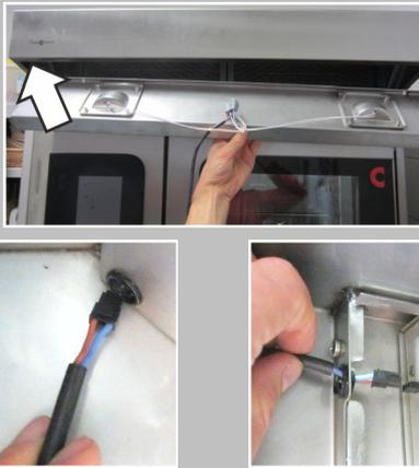
Протяните соединительный кабель подсветки через оба ввода слева снизу колпака для сбора конденсата.
