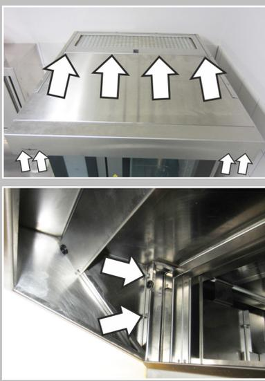
Снова установите кожух на колпак и закрепите его снятыми ранее винтами.
